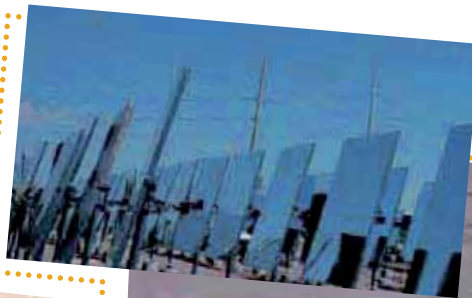
Spiegel des Solarturmkraftwerks
