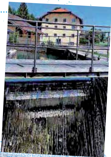
Kleines Wasserkraftwerk am Fluss
