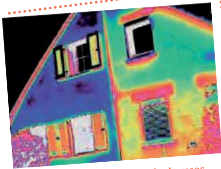
Wärmebild eines Wohnhauses rot = schlechte Wärmedämmung grün = mittlere Wärmedämmung blau = gute Wärmedämmung
