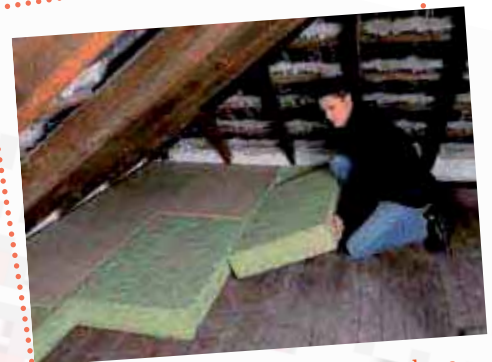
Wärmedämmung des Dachbodens
