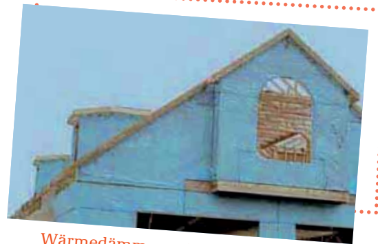
Wärmedämmung der Außenfassade
