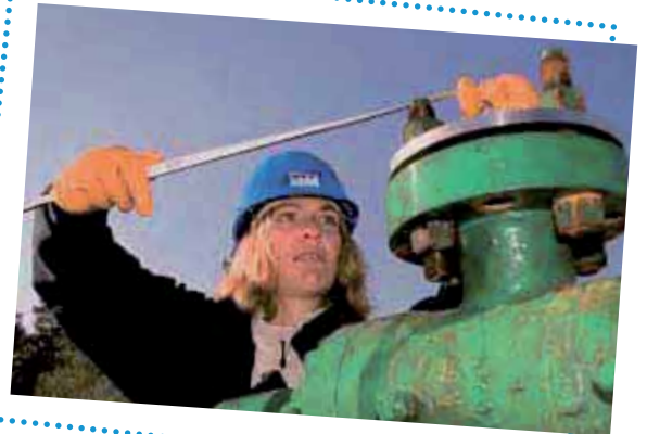
Technikerin überprüft Ventil (Geothermiebohrung)
