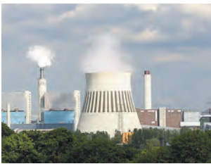
Abbildung 13 Das Kohlekraftwerk Reuter West in Berlin
