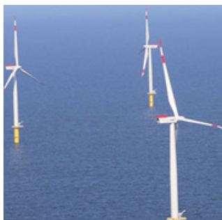
H&M Ingenieurbüro GmbH&Co. KG/wikimedia commons/CC BY-SA 4.0
